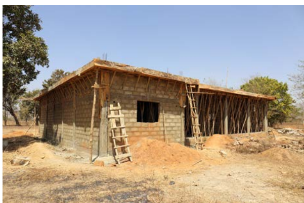
Construction de la future salle polyvalente
