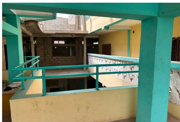
Chantier de l'extension – surélévation (22.02.2025)
