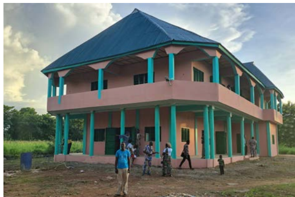
Bâtiment avec extension – surélévation (12.09.2024)
